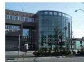
市民防災センター
